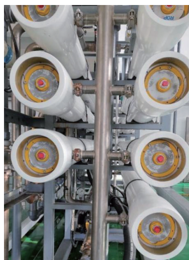
图 7 南部海域某岛海水淡化装置钛制高压管路运行 8 年后情况
